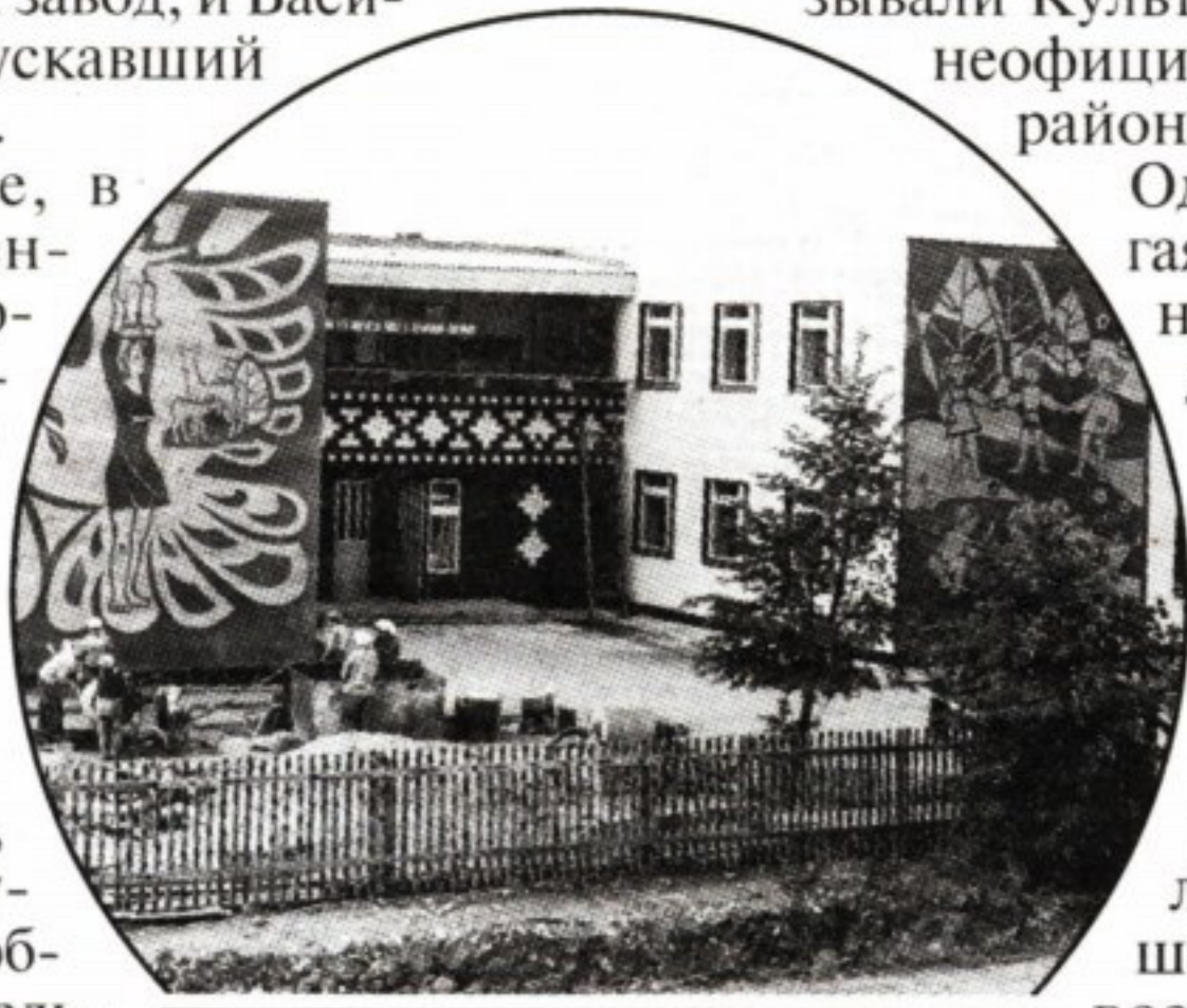
Сегодня в районе Культбазы 19 детских садов. На снимке - один из них, выстроенный для детей работников Ижевского сельского строительного комбината. 1985 год.
