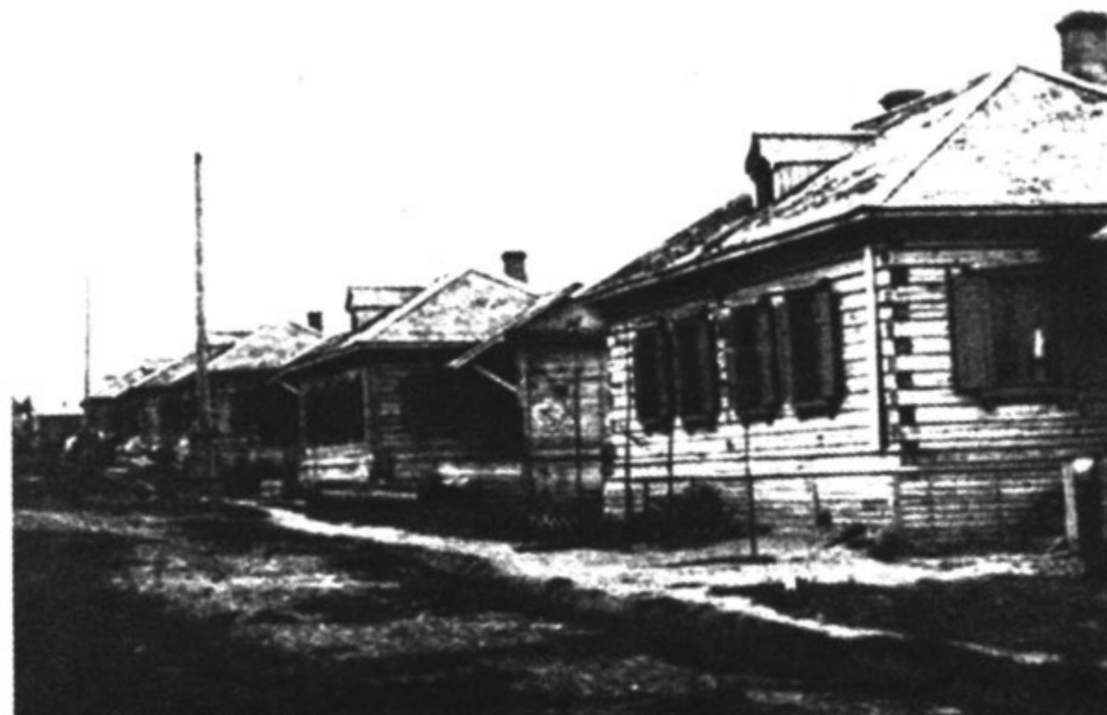
Строительство нового района Культбазы, 1948 год
